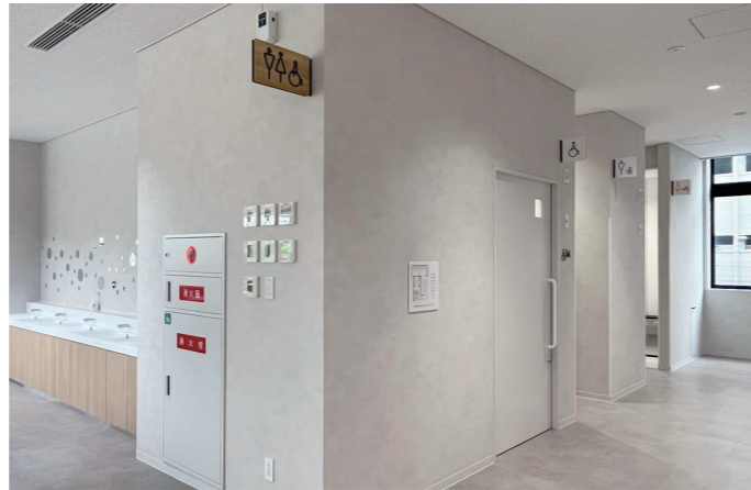
1F 食堂 トイレ入口
