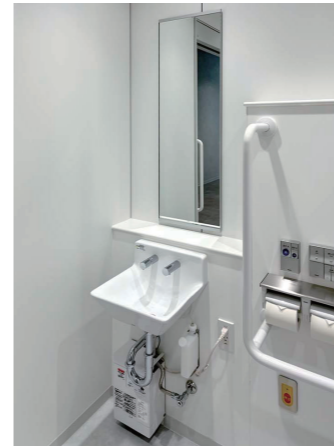
1F 食堂 バリアフリートイレ
