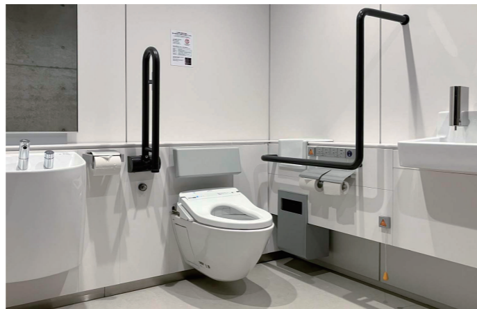
1F 多目的トイレ
