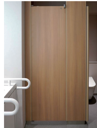
基準階 女性トイレ 大便器コーナー
