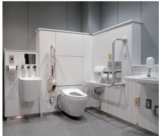
東棟 区民会館ホール2F バリアフリートイレ
