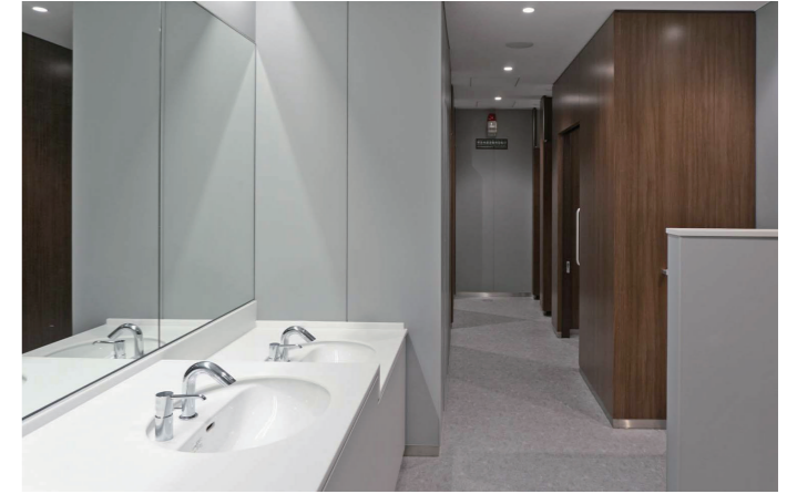
東棟 区民会館ホール2F 女性トイレ 全体
