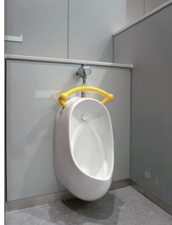
東棟 区民会館ホール2F 女性トイレ
