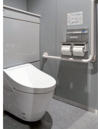
東棟 区民会館ホール2F 女性トイレ 大便器コーナー
