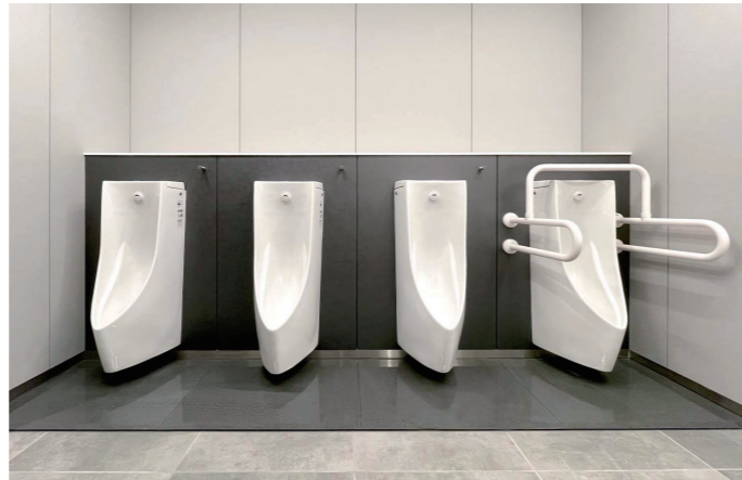
B1南側 男性トイレ 小便器コーナー
