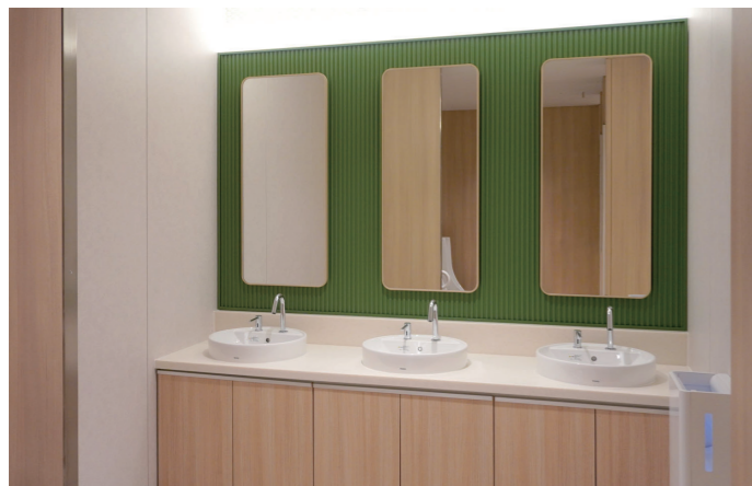
B1北側 男性トイレ 洗面コーナー
