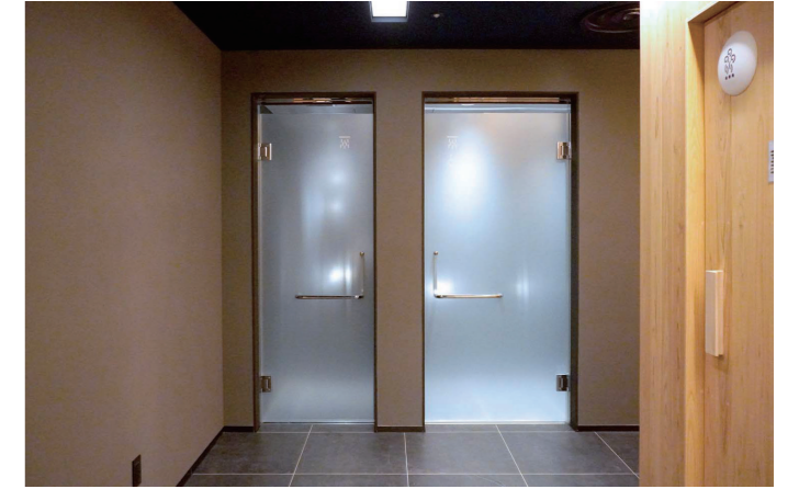
9Fオフィスサポート 女性用サウナ シャワーブース
