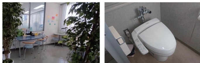
カウンセリングセンター改修前
