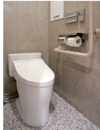
1F小ホール 男性トイレ 大便器ブース
