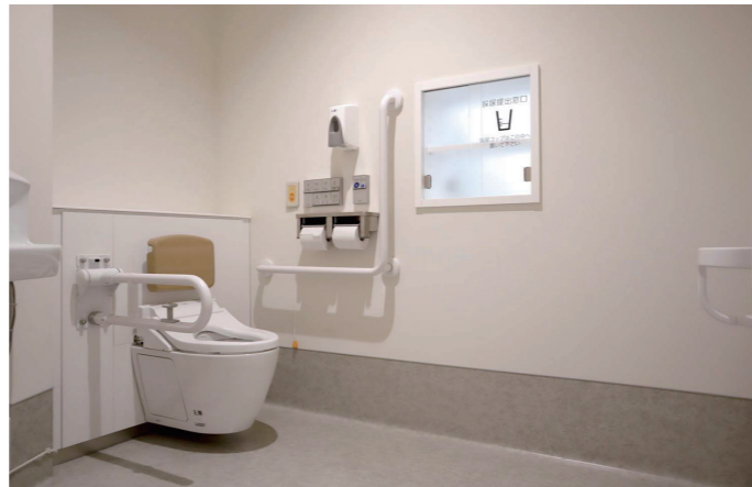
2F 採尿トイレ バリアフリートイレ
