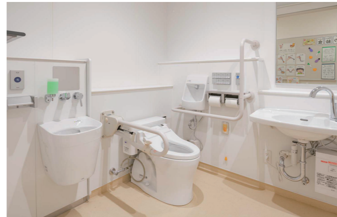
豊中市立庄内さくら学園 北校舎1F バリアフリートイレ
