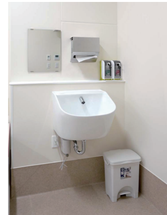
豊中市立庄内さくら学園 北校舎1F 配膳室
