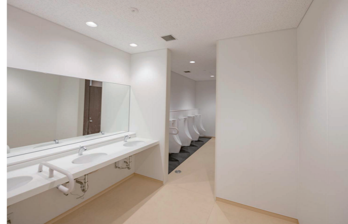
豊中市立庄内さくら学園 南校舎1F 職員用トイレ
