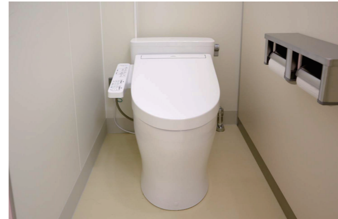
女子トイレ 大便器ブース
