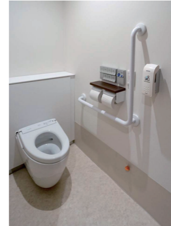
3F病棟階 男性トイレ大便器コーナー
