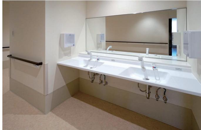
3F病棟階 廊下洗面コーナー
