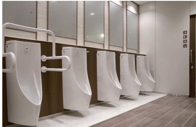
B1F東側 男性トイレ 小便器コーナー
