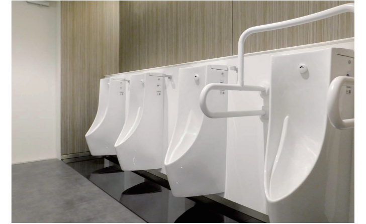
オフィスフロア 基準階 男性トイレ 小便器コーナー
