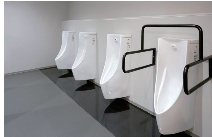
本庁舎 4F 男性トイレ 小便器コーナー
