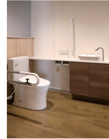
多目的トイレ
