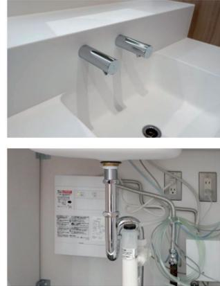
洗面コーナーには、非接触で使用できる自動水栓と自動水石けん供給栓を採用。電気温水器も設置され、お湯が使える快適な仕様となっている。
