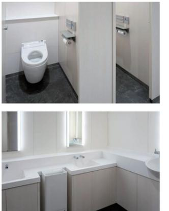
奇数階共用部は女性専用トイレとしたため、専有スペースに男性トイレを増設。配管がなかったことからパイプスペースを新設、床上配管で接続。小便器はライニングを設置し給排水をつなぎ、大便器は壁掛式を選定した。
