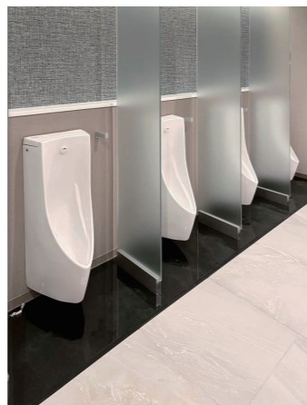
温浴棟2F 男性トイレ 小便器・大便器コーナー
