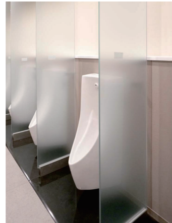
食楽棟1F 男性トイレ 小便器コーナー
