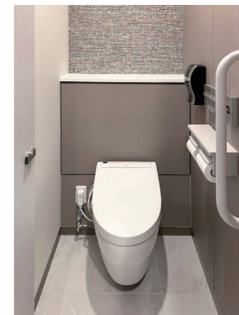
温浴棟2F 女性トイレ 大便器ブース
