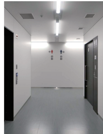
2F南西エリア トイレ入口
