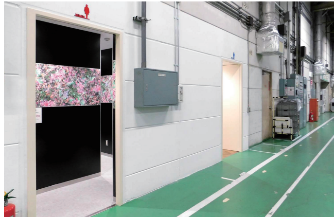
B6棟1F北西 トイレ入口
