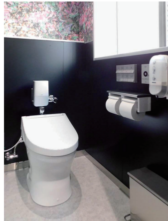
B6棟1F北西 女性トイレ 大便器ブース
