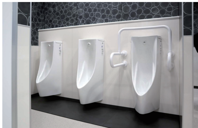
C1棟2F西南 男性トイレ 小便器コーナー
