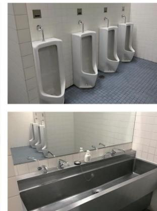
築25年以上が経過した既存のトイレは、洋式化されていたものの、清掃方法は湿式清掃であったため、床の汚れが目立っていた。また、洗面コーナーの水栓金具や大便器の洗浄は、手動式の器具が使用されていた。
