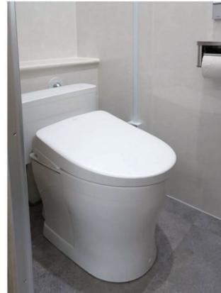
開口部を広く確保し、入退室にスペースとらない折戸を採用した大便器ブースには、広さを変えずに設置できるパブリックコンパクト便器・フラッシュタンク式を採用。電気工事が不要なエコリモンを選定している。
