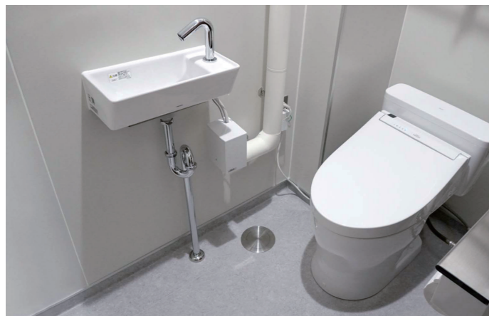
低層棟B1F 厨房トイレ
