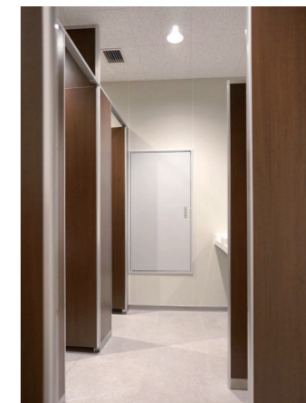
高層棟3F 女性トイレ 大便器コーナー
