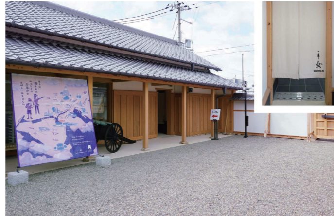
旧船見番小屋 トイレ入口
