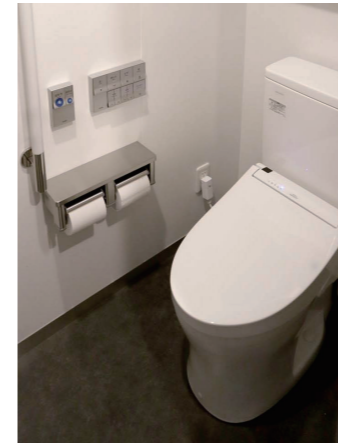
北側女性トイレ 大便器ブース
