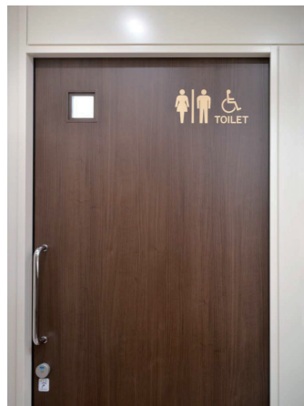
バリアフリートイレ入口
