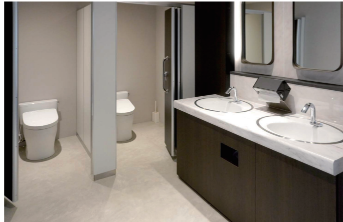
3F 女性トイレ 全体
