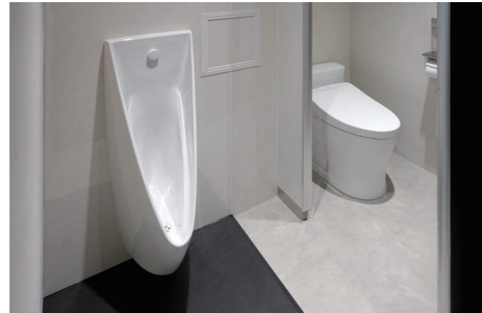
1F 男性トイレ 小便器・大便器コーナー
