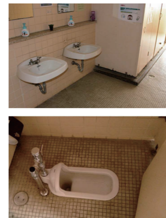
管理棟 改修前
