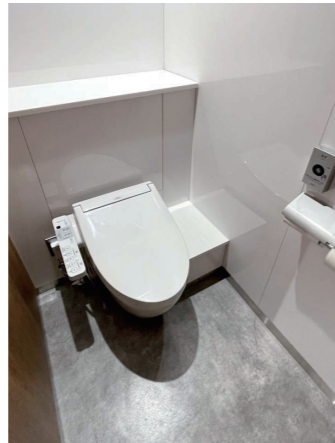
4号館(志学館)2F 男性トイレ 大便器ブース
