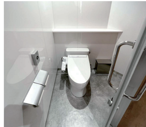
4号館(志学館)1F 女性トイレ 大便器ブース
