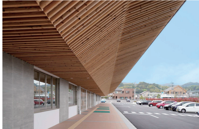
玄関・駐車場
