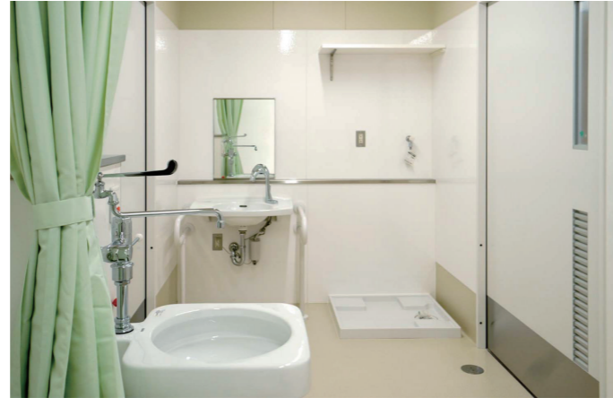
1F教室トイレ 洗面・洗濯機まわり
