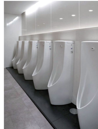
校舎D階段2F 男性トイレ 小便器・大便器コーナー
