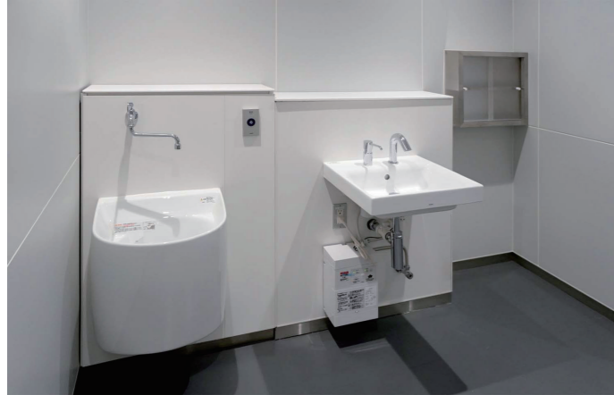
1F保健センター 検査室(検体)
