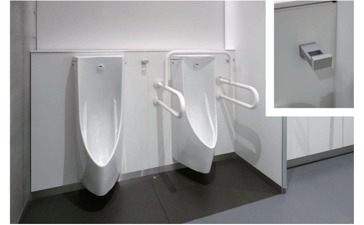
1F南側 男性トイレ 小便器コーナー
