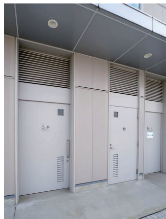
外部 男女共用トイレ
