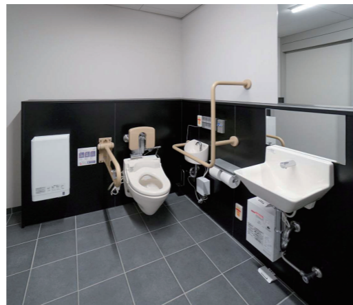
外部 車いす対応トイレ
