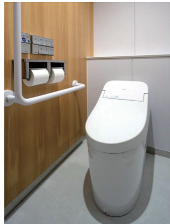
5F 女性トイレ 大便器ブース
