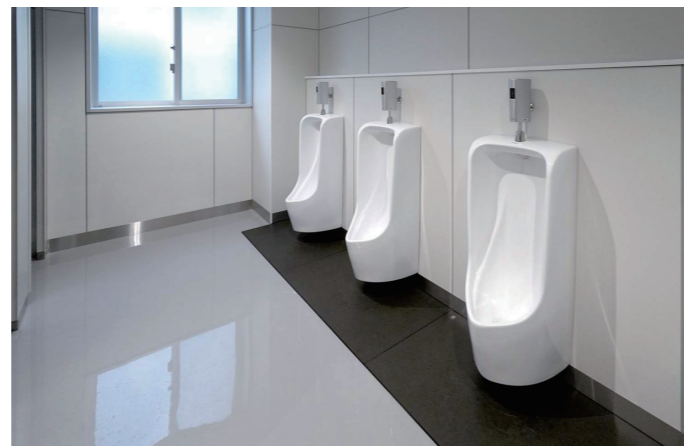
工場棟1F 男性トイレ小便器コーナー
