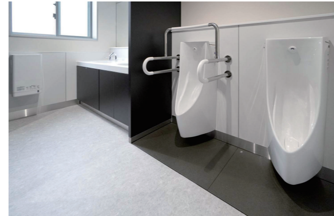
事務所棟3F 男性トイレ小便器コーナー
