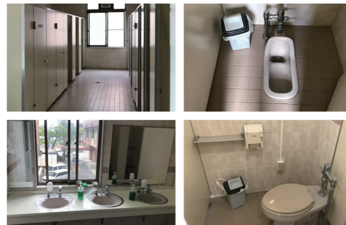
2F女子トイレ 改修前
