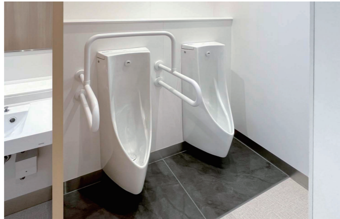
6F来客・職員用トイレ 小便器コーナー
