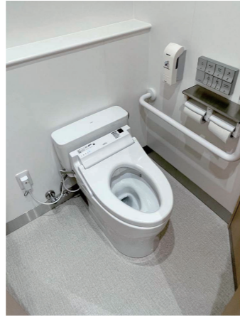
6F男子トイレ 大便器ブース
