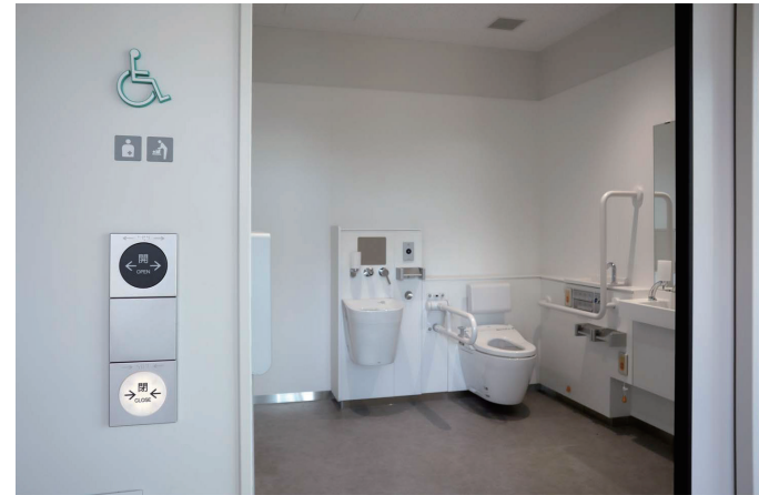
2F 多目的トイレ
