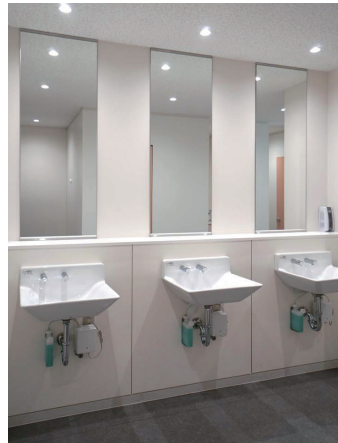
1F女子トイレ 洗面コーナー・大便器ブース
