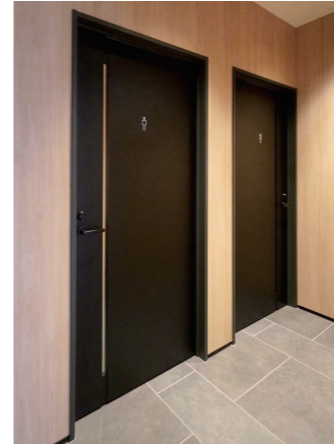
1F女性トイレ 入口
