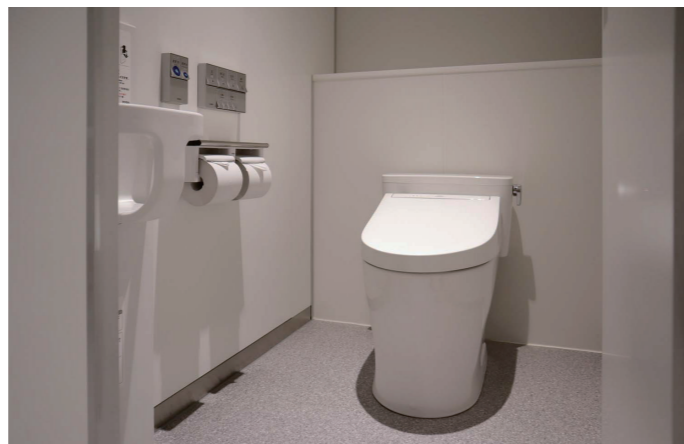
1F 女性トイレ 大便器ブース
