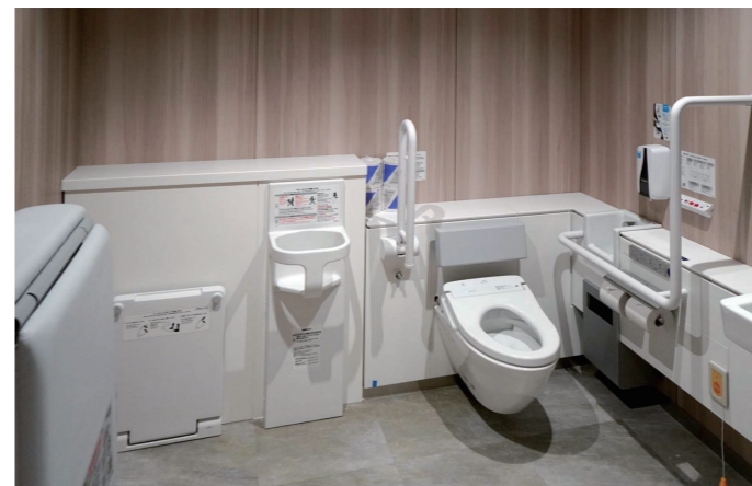
1F エアラインカウンター前 バリアフリートイレ
