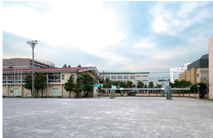
草加市立花栗南小学校 屋内運動場 外観
