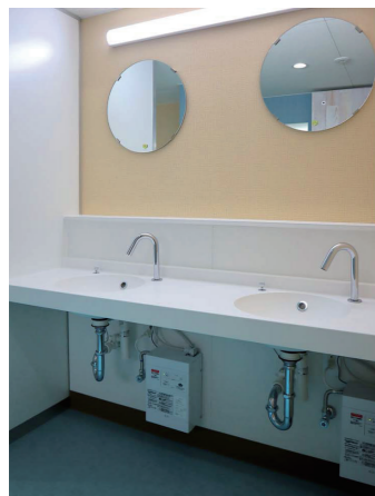
第1サークル棟 男性トイレ 洗面コーナー
