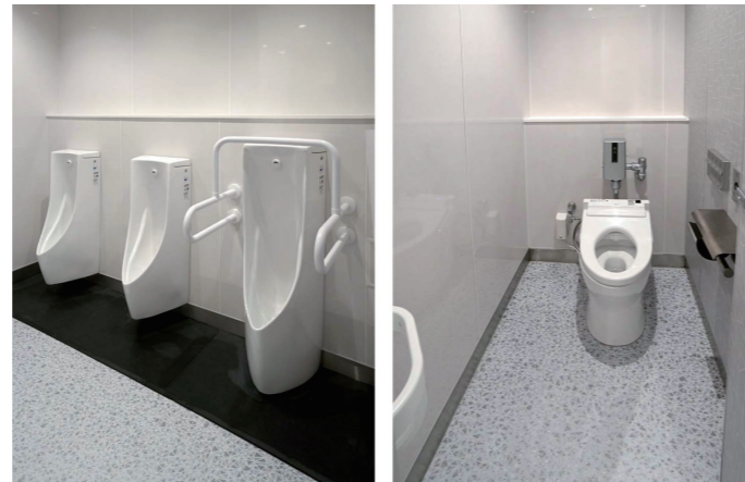
男性トイレ 小便器コーナー・大便器ブース
