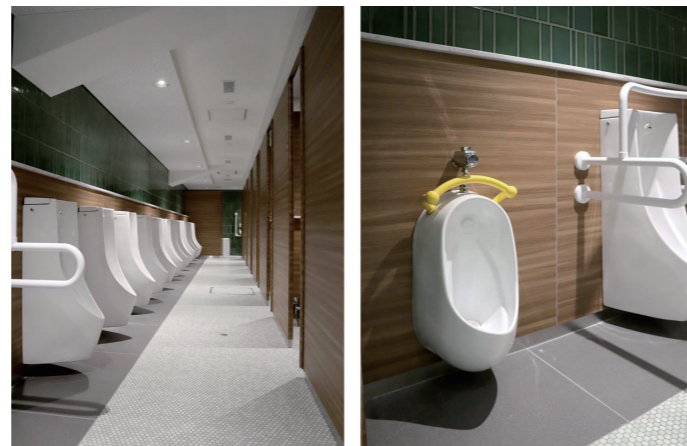
大ホール 1F男性トイレ小便器コーナー
