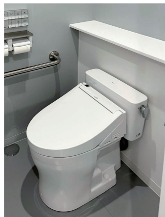
男性トイレ 大便器ブース
