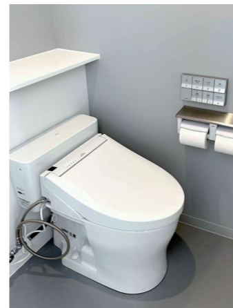
女性トイレ 大便器ブース
