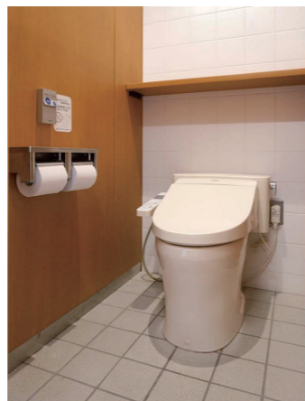
東館トイレ 大便器ブース
