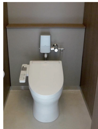
1F 女性トイレ 大便器ブース
