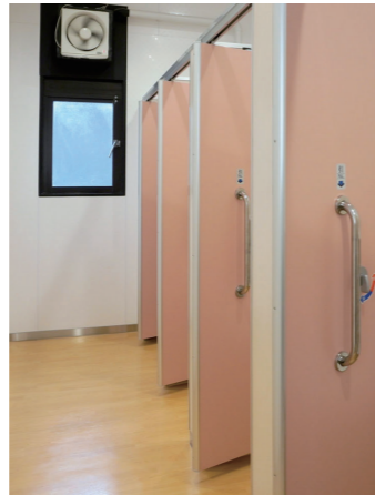
3Fトイレ 全体
