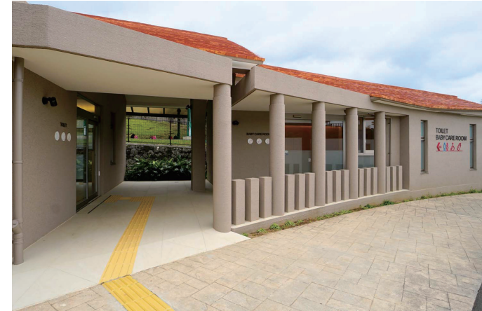
トイレエントランス
